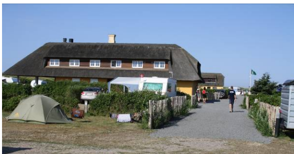
Figur 6 Servicebygning beliggende indenfor planområdet
